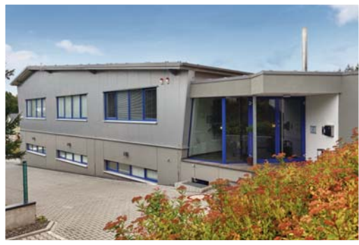
Produktionsgebäude in Rheinland-Pfalz
